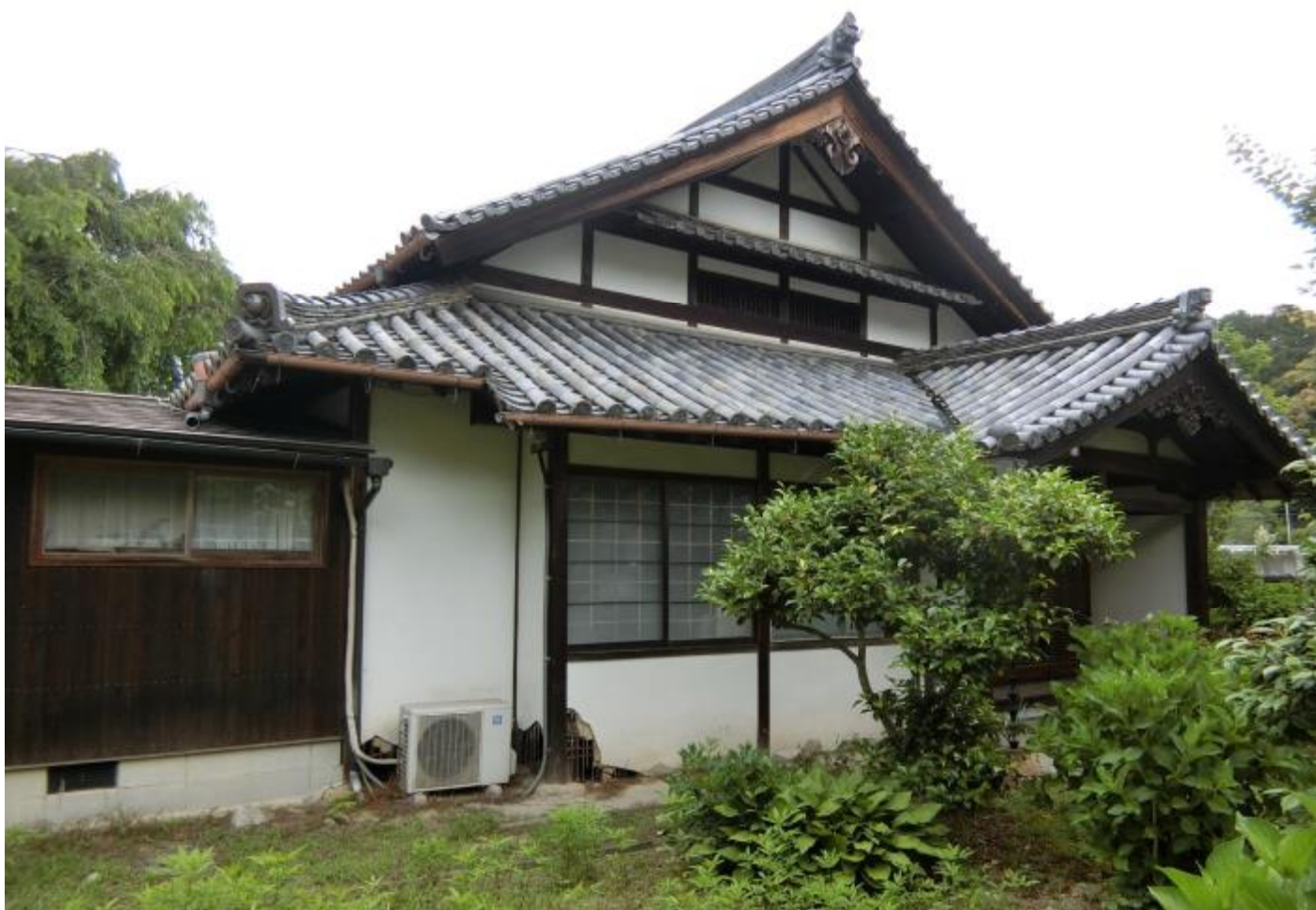
史跡金剛寺境内 ④史跡北部の子院遺構群地区 吉祥院庫裏（南から）
