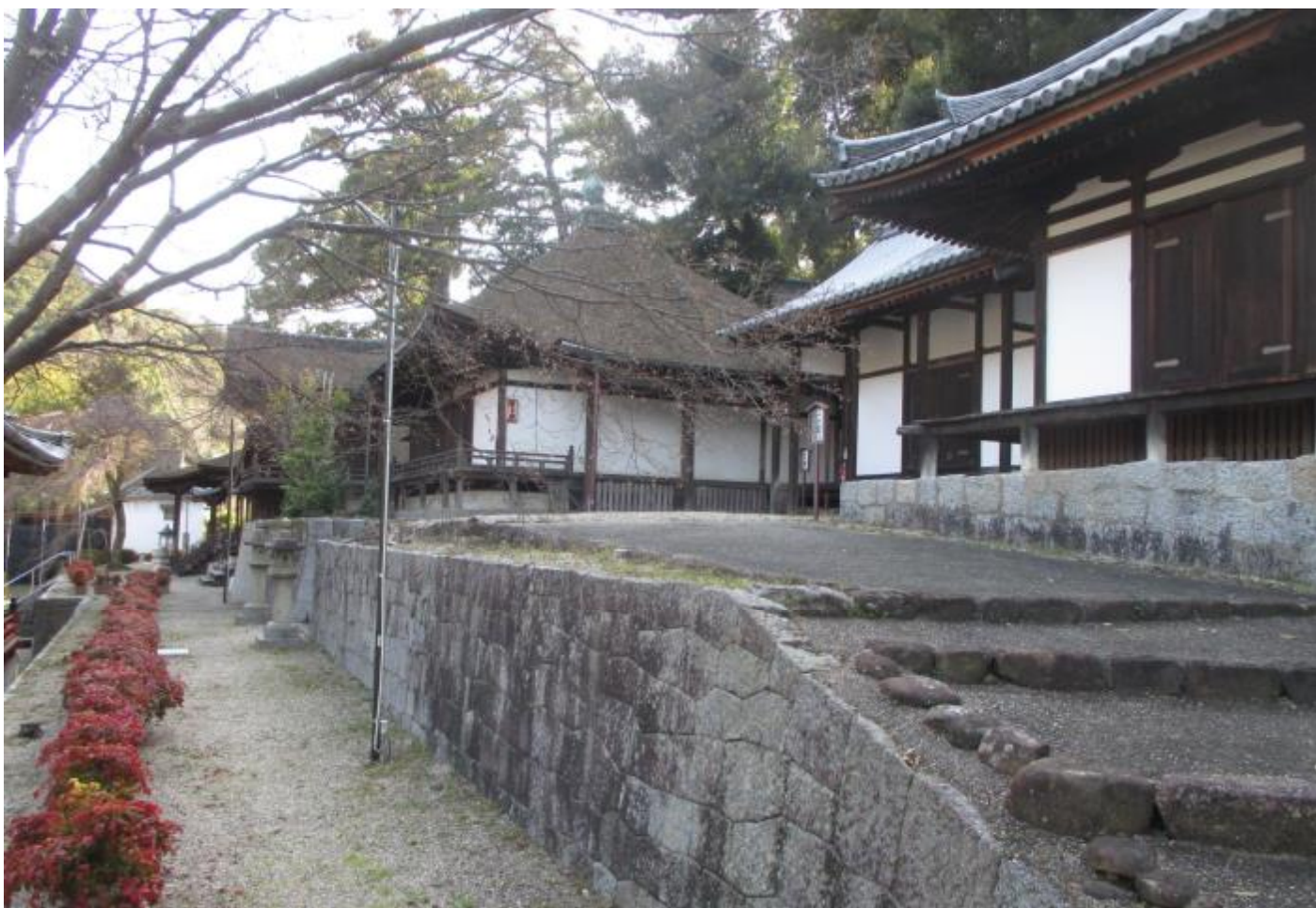
史跡金剛寺境内 ①中心伽藍地区 三宝院伽藍（北から）
